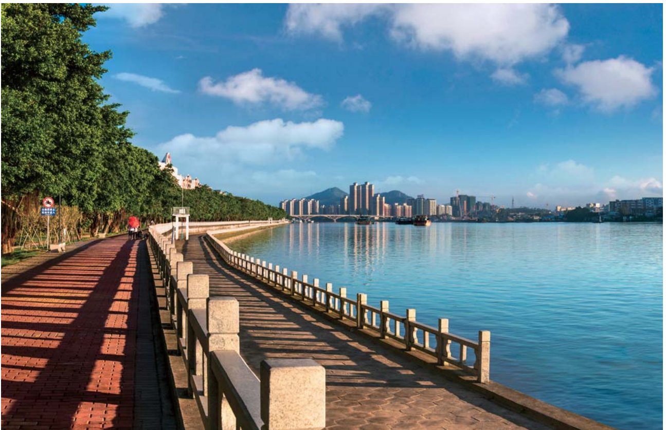
珠海分行支持珠海市斗门井岸镇防洪堤加固工程项目建设
