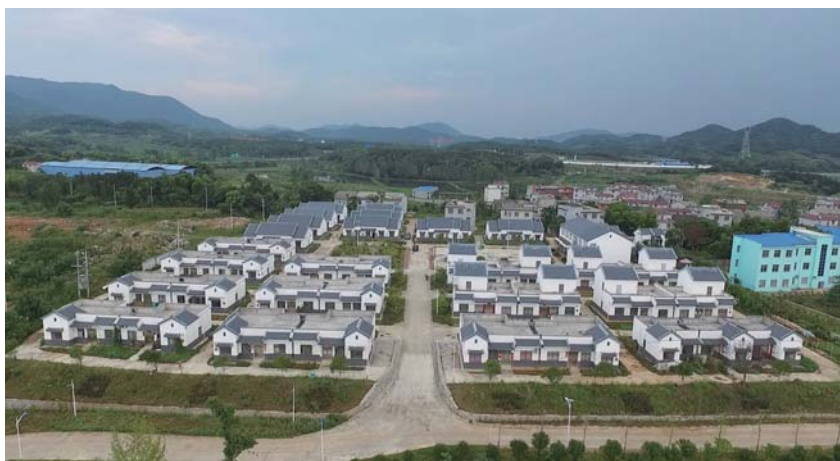
农发行支持的漕河镇刘榜村小区安置点项目
