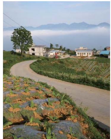
农发行支持的贵州省毕节市通村油路建设
