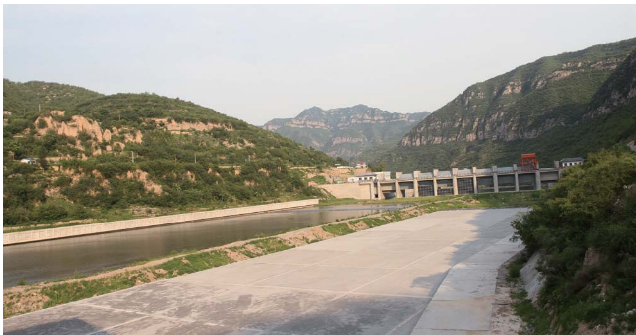
山西分行支持辛安泉供水改扩建工程项目
