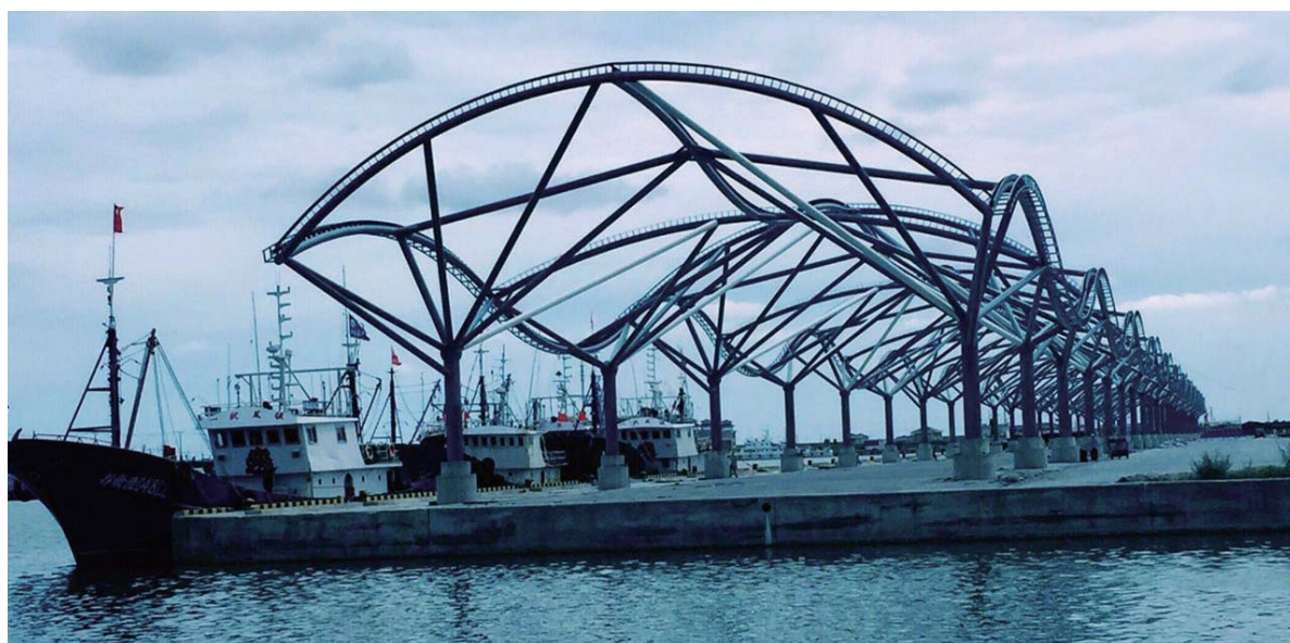
南通分行支持启东吕四港老渔港综合整治工程建设项目
